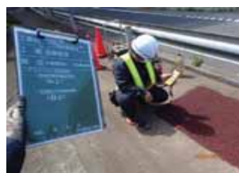
アスファルト温度試験
