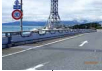
Cランプ 低位置照明 橋梁高欄部取付
