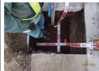
低位置照明掘削幅測定
