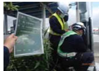
社内検査 (国府津IC現場)
