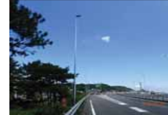
Bランプ 道路照明 12m柱設置
