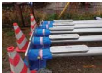
資材保管状況 (屋外)
