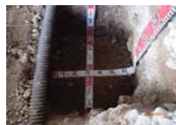
低位置照明基礎砕石幅測定
