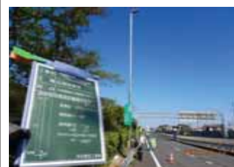
道路照明灯据付高さ測定
