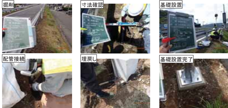
低位置照明基礎設置
