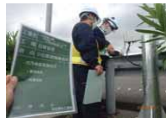
社内検査 (国府津IC現場)
