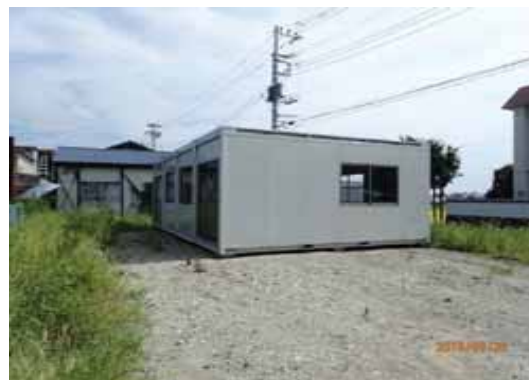
資材倉庫設置
