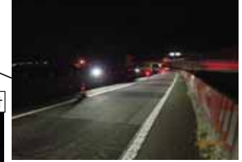
西湘Aランプ 低位置照明 壁高欄部取付
