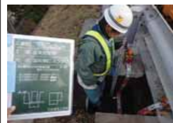
低位置照明掘削深さ測定
