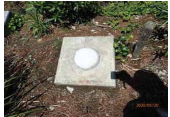
道路照明柱撤去後処理
