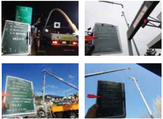
道路照明柱撤去
