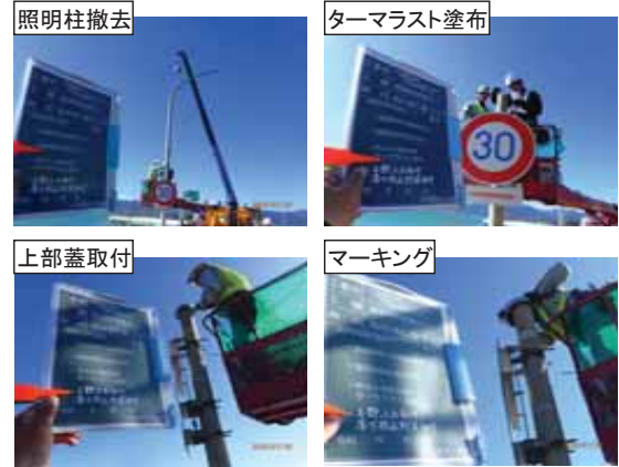
照明柱撤去 (標識共架)
