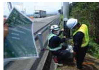
社内検査 (国府津IC現場)
