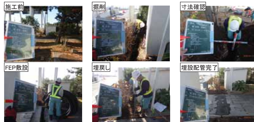
埋設配管敷設
