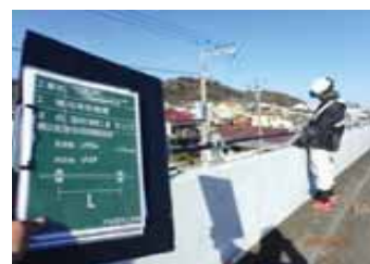
露出配管支持間隔測定
