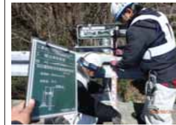
低位置照明支柱建築限界測定
