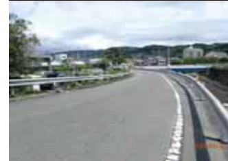
Bランプ 低位置照明 支柱取付
