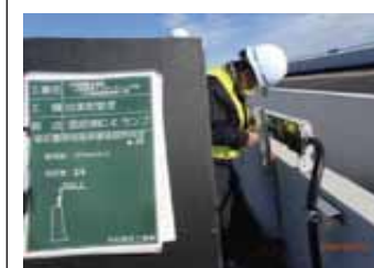
低位置照明器具建築限界測定
