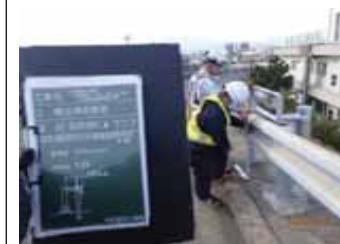
低位置照明支柱建築限界測定
