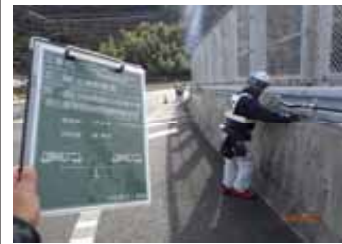
低位置照明器具間隔測定
