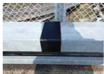
耐候性ゴムシート張り
