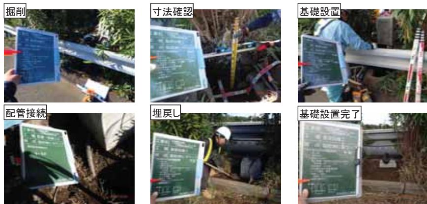
低位置照明基礎設置
