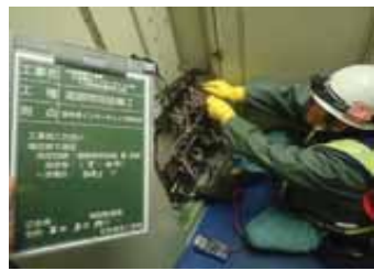
電圧降下測定 (盤側)
