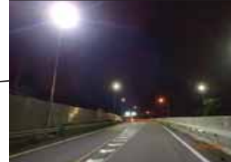
Cランプ 道路照明 12m柱設置
