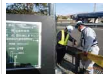
道路照明柱建築限界測定
