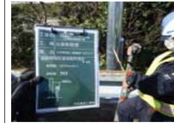
道路照明柱建築限界測定
