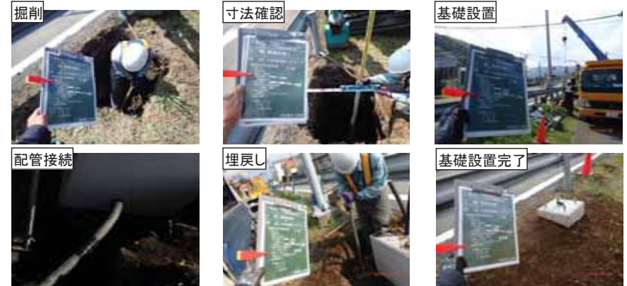
道路照明基礎設置
