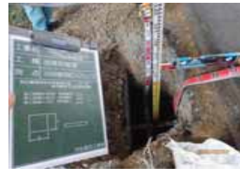
低位置照明基礎砕石厚さ測定
