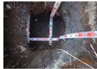
低位置照明掘削幅測定
