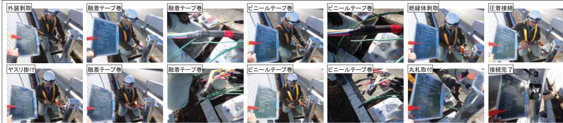
低位置照明支柱内結線
