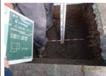
低位置照明基礎砕石厚さ測定
