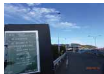
道路照明灯据付高さ測定
