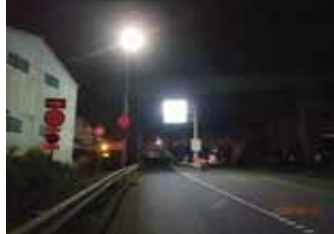
本線上り 道路照明 10m柱設置
