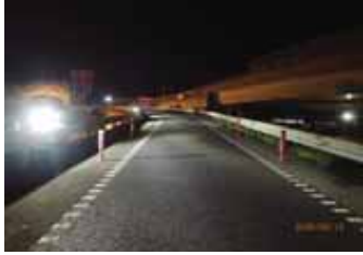
Cランプ 低位置照明 壁高欄部取付
