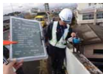
アンカー引張試験
