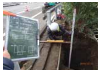
道路照明基礎掘削深さ測定
