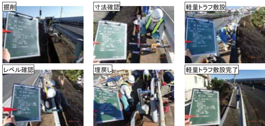
軽量トラフ敷設
