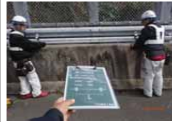
露出配管支持間隔測定
