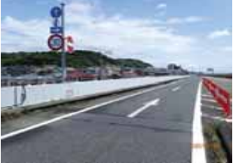
Aランプ 低位置照明 壁高欄部取付
