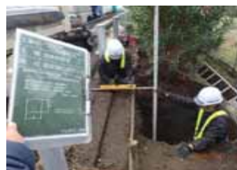
道路照明基礎砕石厚さ測定
