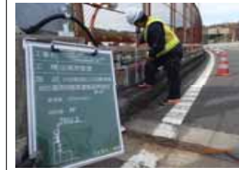
低位置照明器具建築限界測定
