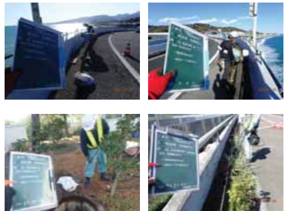
既設ケーブル撤去
