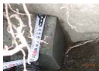
ダクト口工寸法測定
