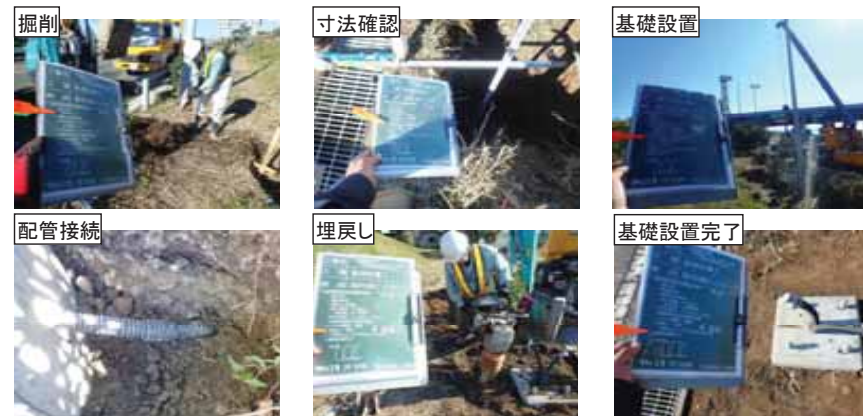
道路照明基礎設置
