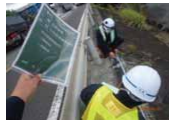
社内検査 (国府津IC現場)
