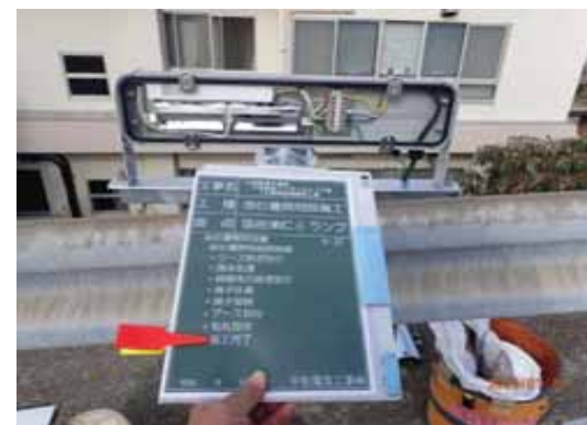
低位置照明器具設置完了
