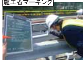
施工者マーキング
