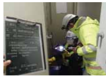
絶縁抵抗試験 (改修後)
