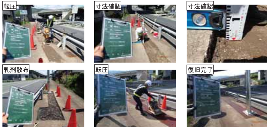
アスファルト舗装復旧
