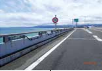
Dランプ 低位置照明 橋梁高欄部取付
