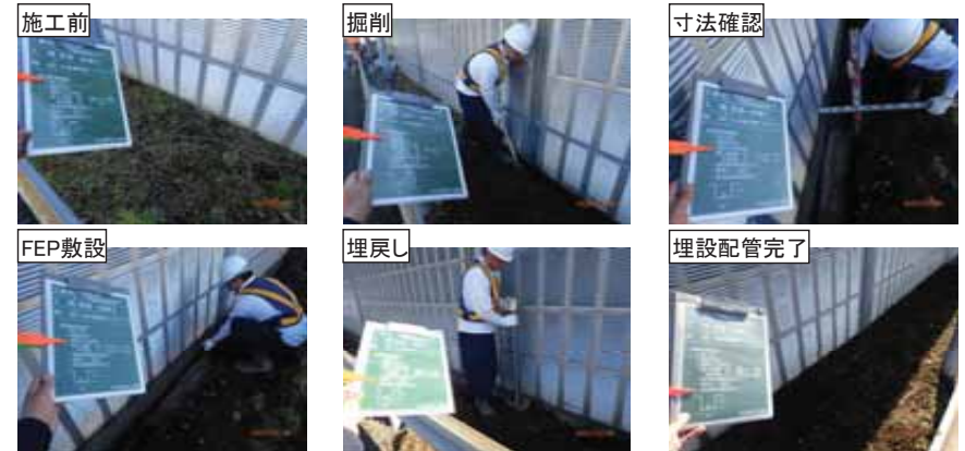
埋設配管敷設
