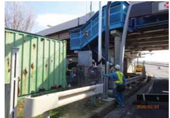
安定器盤撤去
