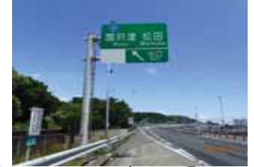
Bランプ 道路照明 12m柱設置
