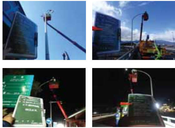
道路照明柱器具撤去
