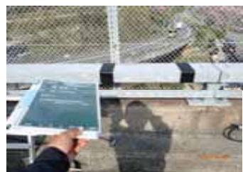
耐候性ゴムシート張り
