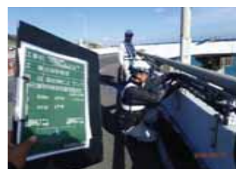
低位置照明器具間隔測定
