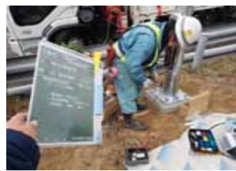
絶縁抵抗試験 (敷設後)
