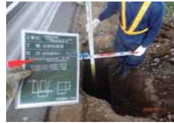
低位置照明掘削深さ測定
