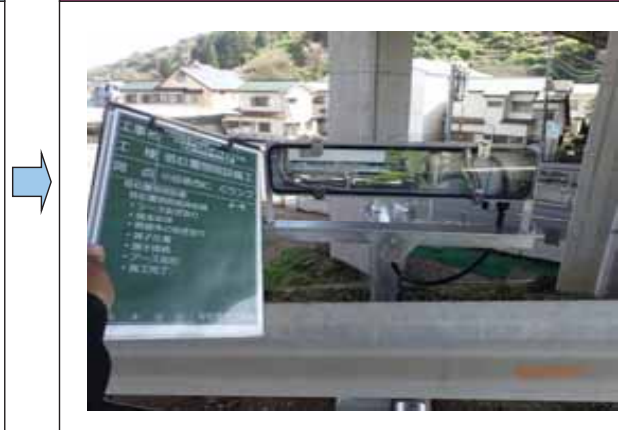
低位置照明器具設置完了
