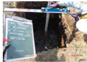
道路照明基礎砕石厚さ測定
