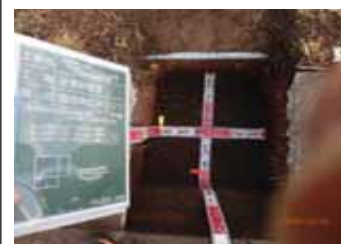
低位置照明基礎砕石幅測定
