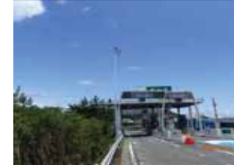
Bランプ 道路照明 2灯用照明塔設置
