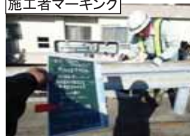
施工者マーキング
