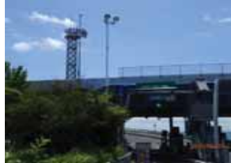
Cランプ 道路照明 2灯用照明塔設置
