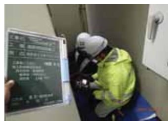
絶縁抵抗試験 (施工前)
