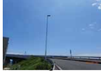
Cランプ 道路照明 10m柱設置
